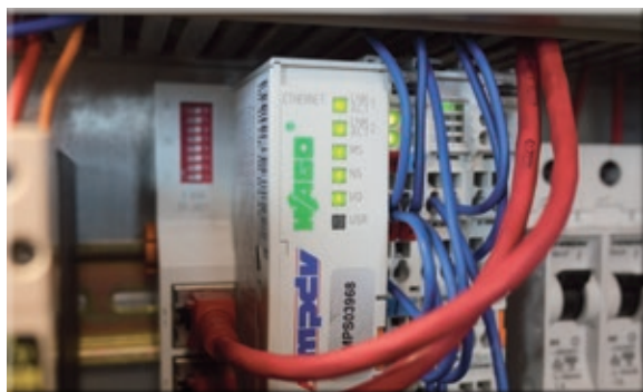
Einfache Erfassung der Energieverbräuche dank Schnittstellenbaustein von MPDV.
